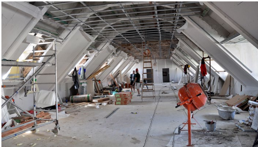
Izolace podkrovního depozitáře. Foto: Pavel Macenauer
