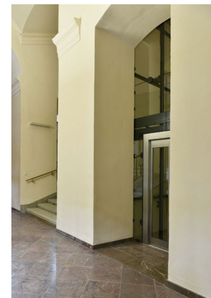
Hlavní schodiště s výtahem
