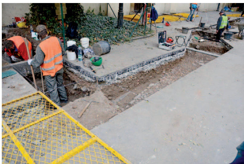
Výkopové práce na Studentském nádvoří. Foto: Eva Hodíková
